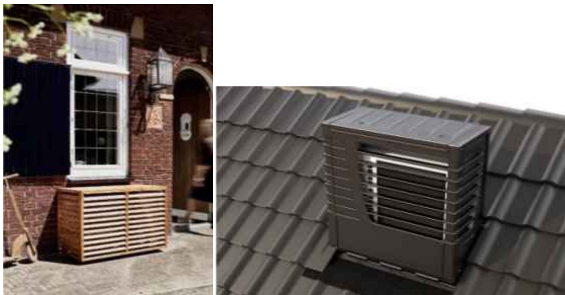
Figuur 2-7 Inpassing luchtwarmtepomp/hybride warmtepomp
