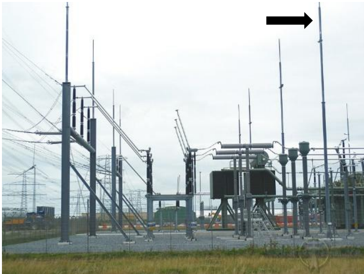
Figuur 1-8 Voorbeeld van bliksempieken. De pijl wijst een bliksempiek aan.
