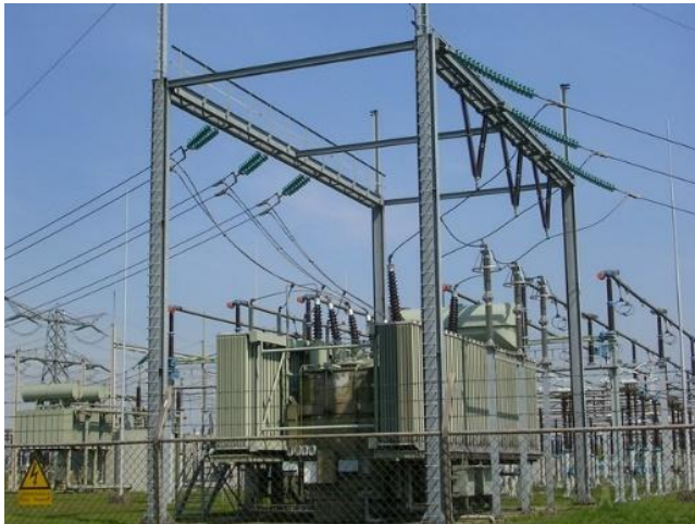
Figuur 1-6 Voorbeeld van een transformator.
