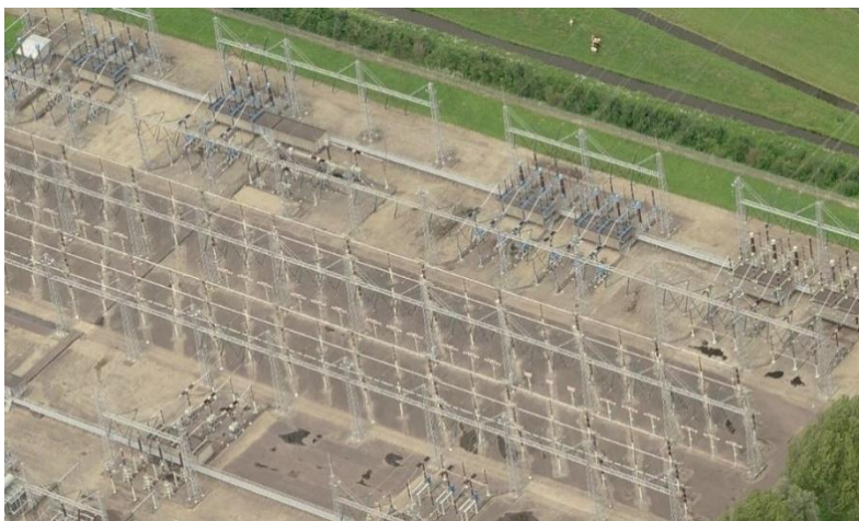
Figuur 1-7 Voorbeeld van schakelvelden.
