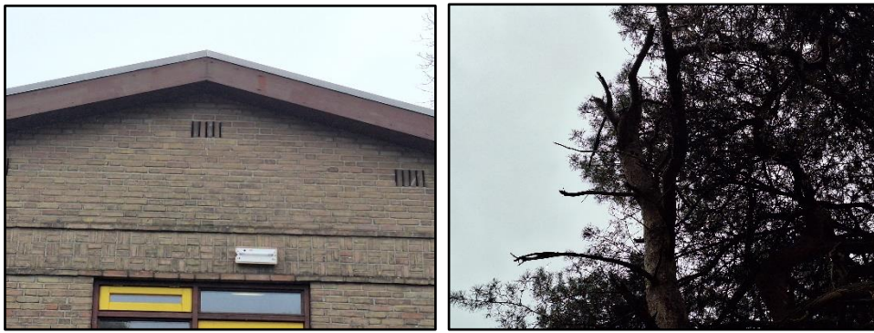
Figuur 2-8: links gebouw met dilatatievoegen, rechts dode boom met holten.
