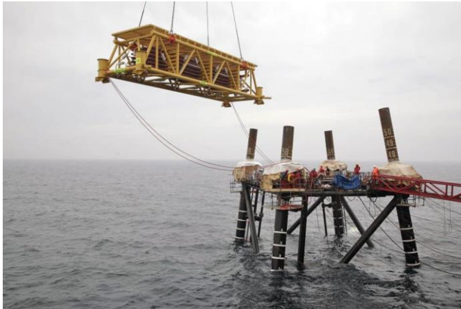
Afbeelding 2.5 Onderwater warmtewisselaar voor een offshore olie- en gasplatform
