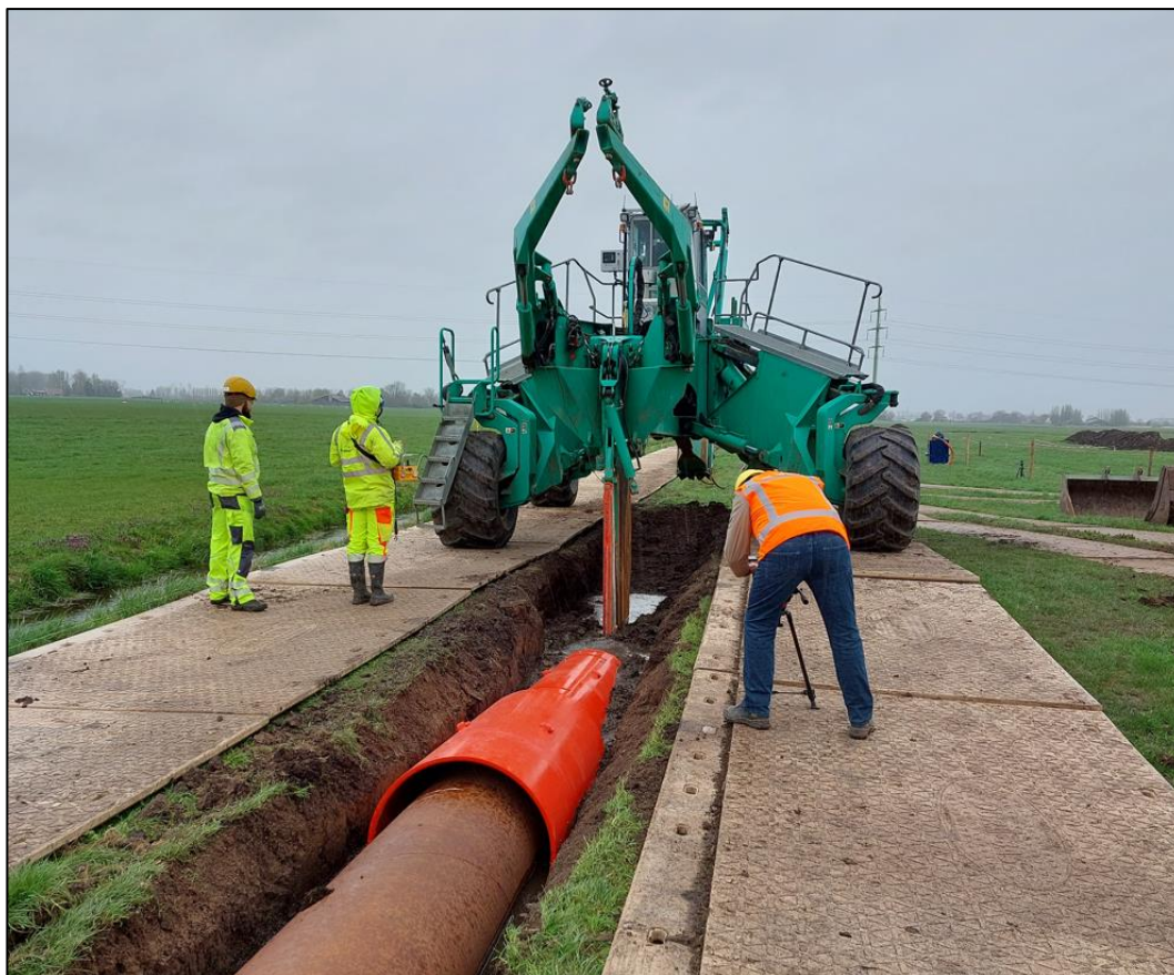
Figuur 3-5: Detail opname 16" torpedo met 28" leiding.
