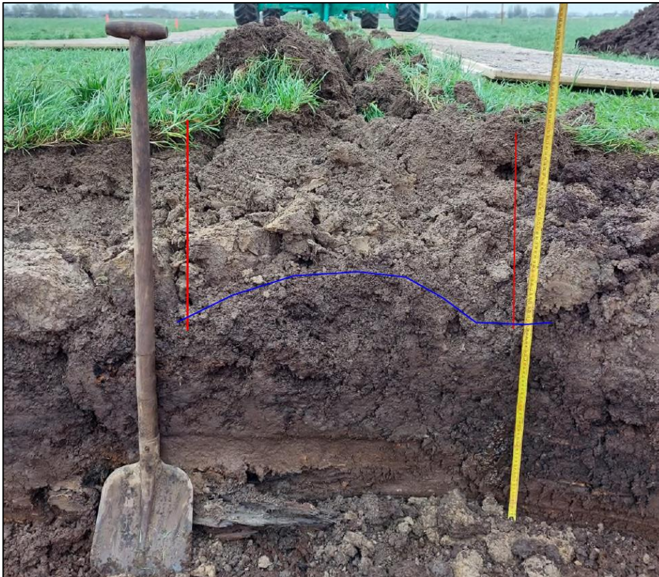
Figuur 5-4: Profielkuil – bodemprofiel tot 1,00 m -mv
