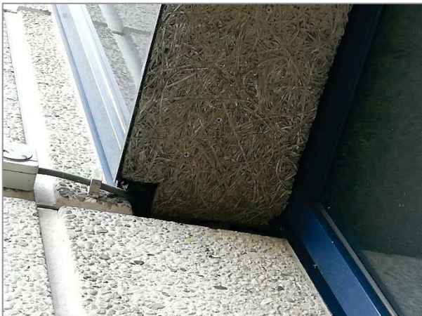
Afbeelding 5.5 | Holte onder de passage op de 1 e verdieping
