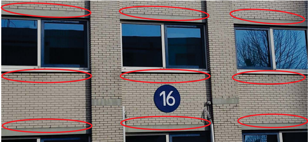
Figuur 4-2. Locaties van de open stootvoegen in het gebouw aan de Planetenbaan 16, welke mogelijk toegang geven tot geschikte verblijfplaatsen voor vleermuizen. In gebouw aan de Planetenbaan 15 bevinden de open stootvoegen zich op dezelfde plekken (foto: RHDHV, 2021).
