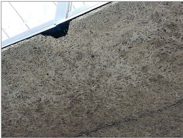
Afbeelding 5.4 | Holte onder de passage op de 1 e verdieping
