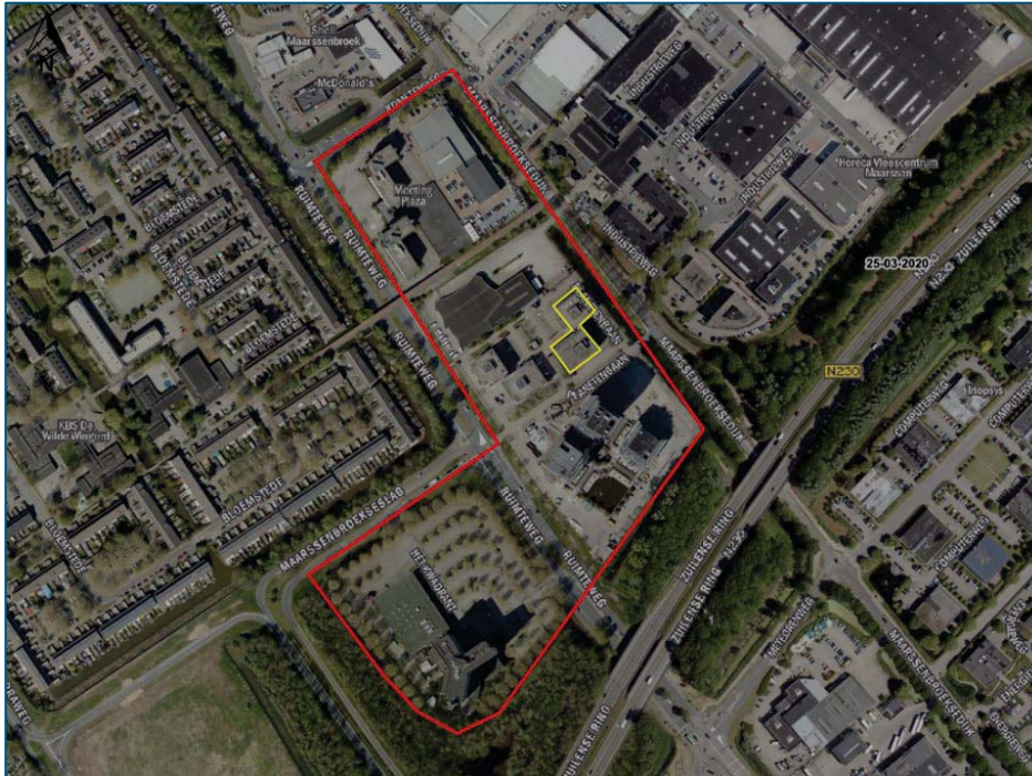
Figuur 7-17 De gebouwen aan de Planetenbaan 15 en 16 met open stootvoegen, welke mogelijk toegang bieden tot geschikte vleermuisverblijfplaatsen (aangegeven in oranje). Het plangebied is weergegeven in rood (Luchtfoto: Cyclomedia, 2021)
