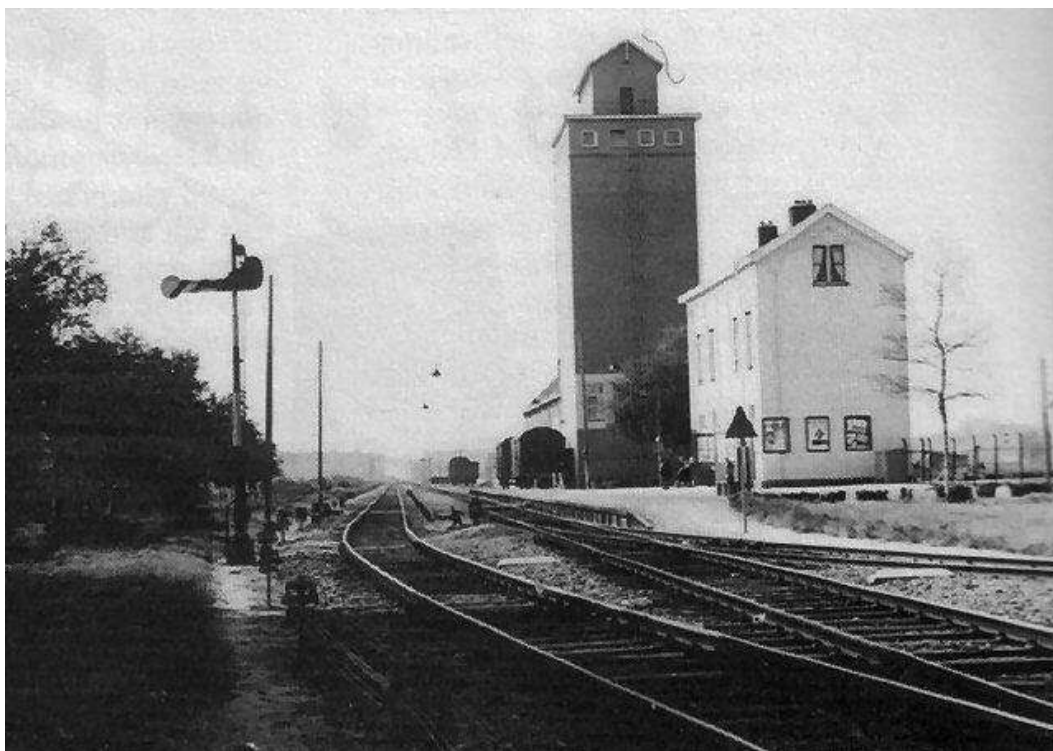
Afb. 18 Het voormalige stationsgebouw te Wehl met direct daar achter het silogebouw. Op de voorgrond is rechts de aftakking naar de Coöperatieve Aan- en Verkoopvereniging (CAVV) zichtbaar.
