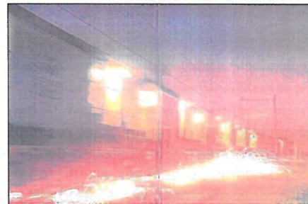
Figuur: Het bijslijpen van spoorstaven.
