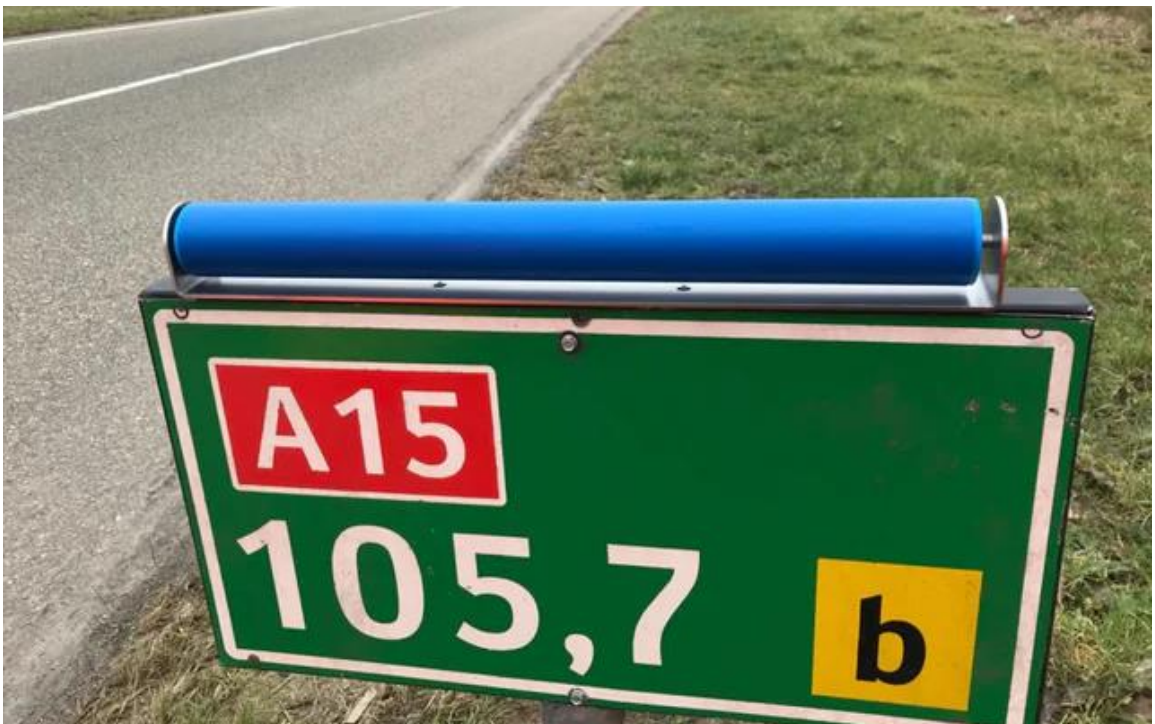
Figuur 6.1. Hectometerpaal van de A15 met roller. Een dergelijke rollerconstructie is ook werkzaam voor borden langs het spoor (bron: RWS).
