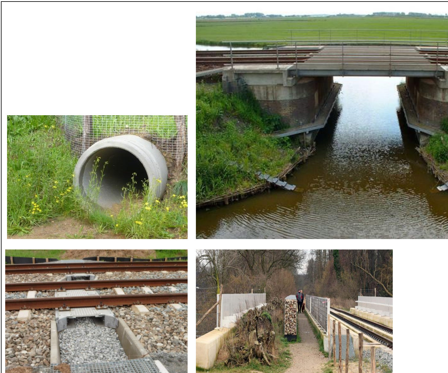
Figuur 3.1. Verschillende vormen van faunapassages. Met van links naar rechts en van boven naar beneden voorbeelden: holle buis constructie; een loopriichel; Dwarsligger FaunaPassage; en groenstrook parallel aan spoor.
