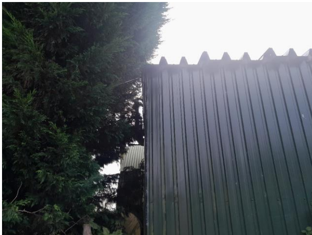
Figuur 3.15: Schuurtje met ruimte tussen golfplaten en onder dak direct aangrenzend aan het spoor (km 42.5 geocode 212).
