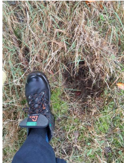
Figuur 3.6: Groter hol direct naast het schouwpad.(km 40.58).
