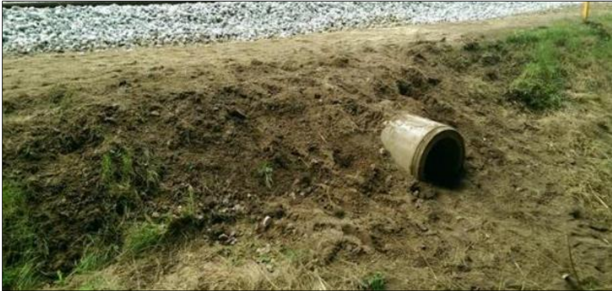
Figuur 4.2: Voorbeeld van een dassentunnel onder het spoor.
