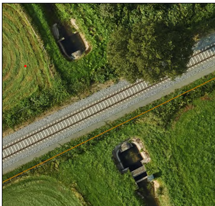
Figuur 4: Waterloop Didamse Leigraaf met de duiker en de stuw aan de zuidzijde. De ligging van het nieuwe spoor (hart spoor) is weergegeven in bruin.
