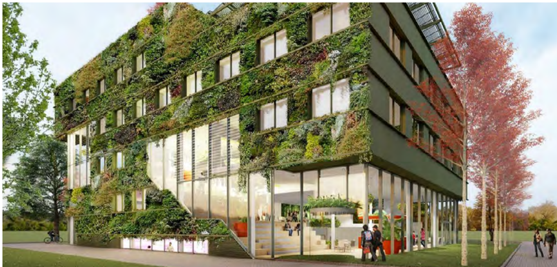
Figuur 2: impressie gebouw Aeres Hogeschool op expo Floriade. Groen en duurzaam schoolgebouw, ontworpen door BDG-architecten met inbreng van medewerkers en studenten
