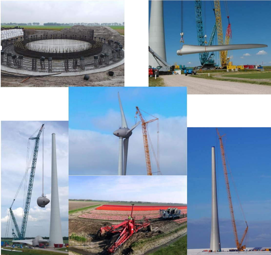
Figuur 2.4 Beelden bouw windturbine en kabelploeg (windpark NOP Agrowind; Bron: www.nopagrowind.nl)
