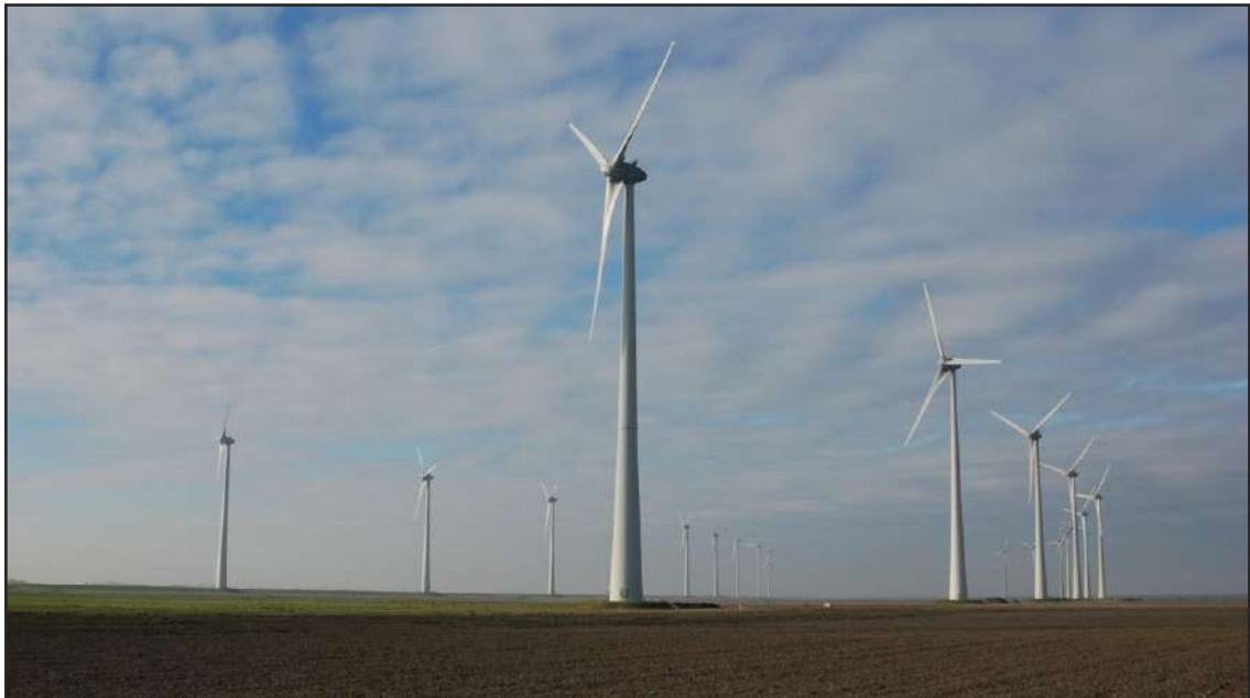
Figuur 7.4 Zicht op de bestaande turbines in de Emmapolder
