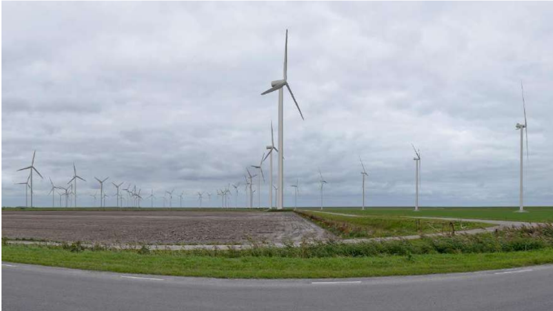
Figuur 15.12 Illustratie verhoogd fundament vanaf standpunt 6
