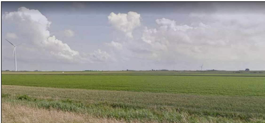
Figuur 9.1 Slaperdijk in de Eemshaven
