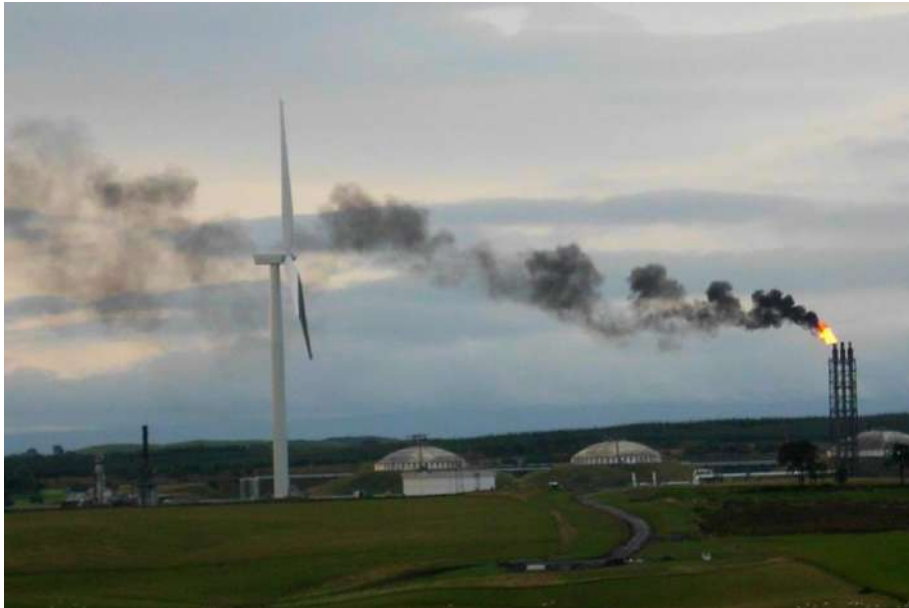
Figuur 2.4 Windmolens kunnen de verspreiding van rook en stof beïnvloeden. Bron foto: Interaction of an Eulerian Flue Gas Plume with Wind Turbines. Timothy M. Fletcher en Richard E. Brown (2010)
