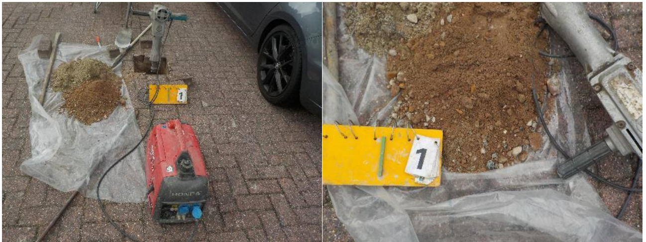
Foto 1: Asbestinspectiegat 01
