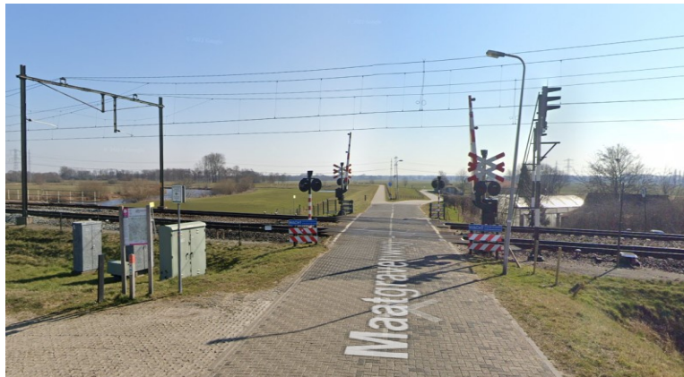
Afbeelding 4.1 Twee voorbeelden van infrastructuur op of naast de dijk waar verkeersstromen kruisen: Boven de kruising van de doorgaande fietsroute Zwolle-Dalfsen bij de Poppenallee en onder de Maatgravenweg, waar na de spoorwegovergang een lokale weg en fietspad splitsen (Bron: Google Maps)
