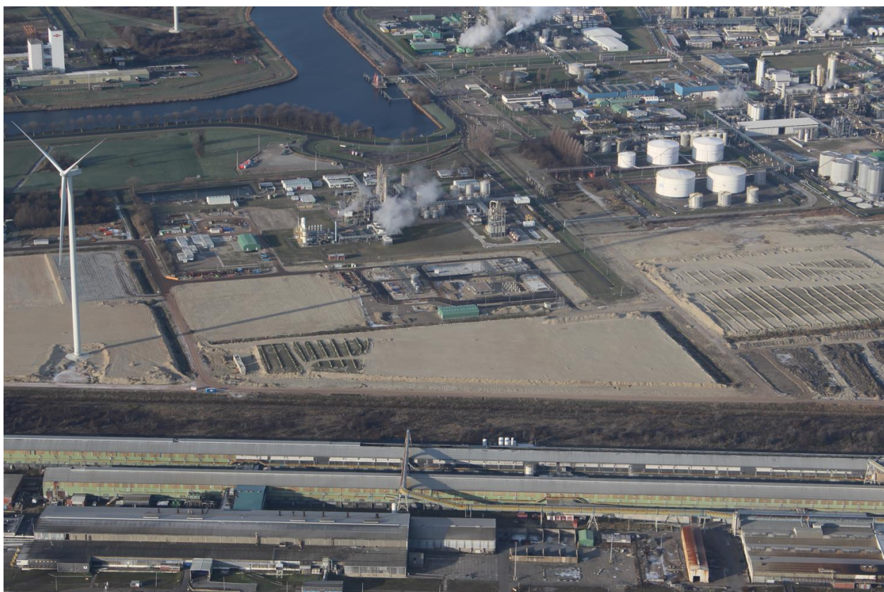
Figuur 6-1: Braakliggend industrieterrein Hevekes
