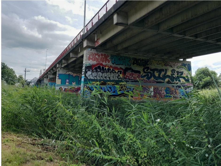
Figuur 1.1.3: Onderzijde van de bestaande brug ter hoogte van de helofytenfilter. Kijkrichting naar het oosten.
