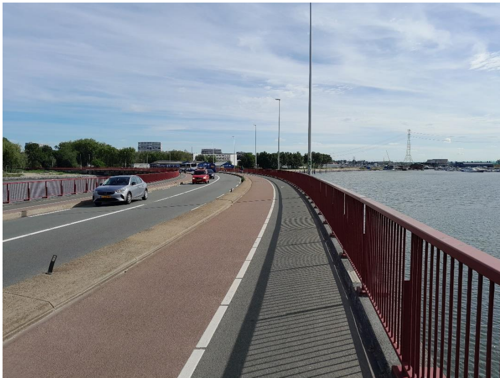
Figuur 1.1.2: Het brugdek van de Zuiderzeeweg met uitzicht op het IJmeer. Kijkrichting naar het westen.
