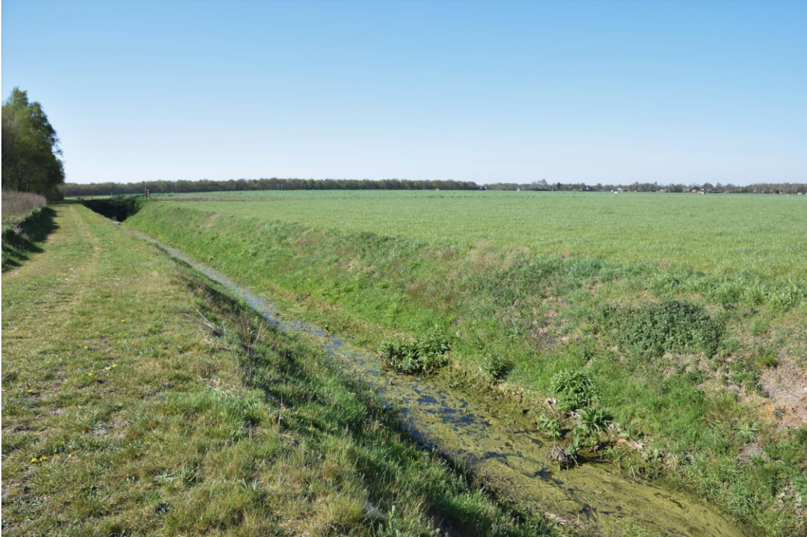
Afbeelding 2.5 Bestaande A-watergang de Noordenveldsewijk
