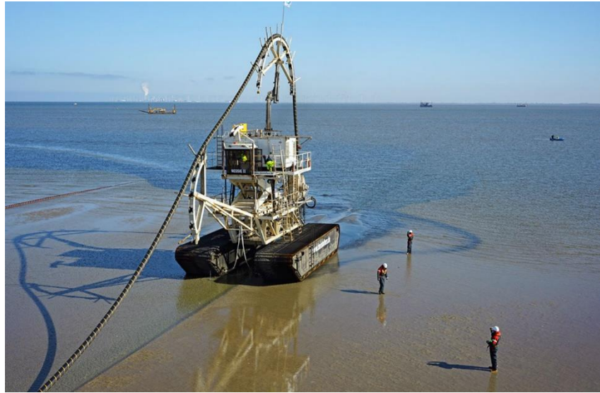
Afbeelding 21. Kabel installatie door de Nessie II
