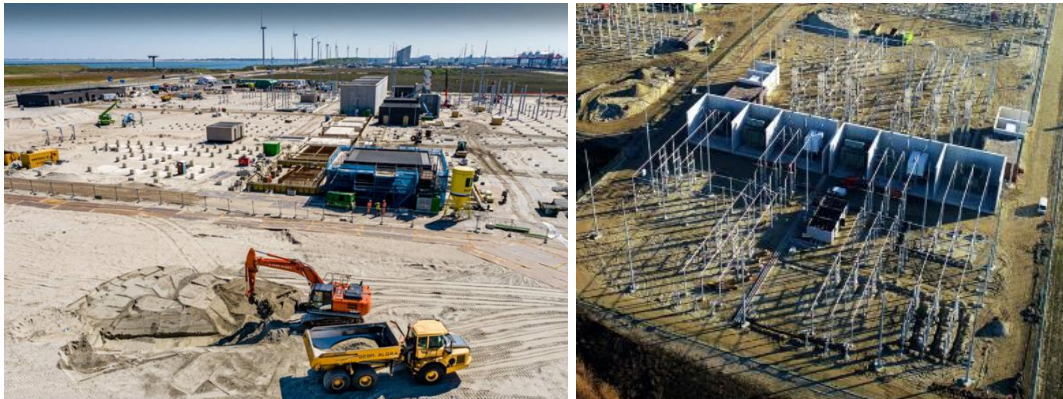
Afbeelding 34. Foto's van werkzaamheden aanleg transformatorstation
