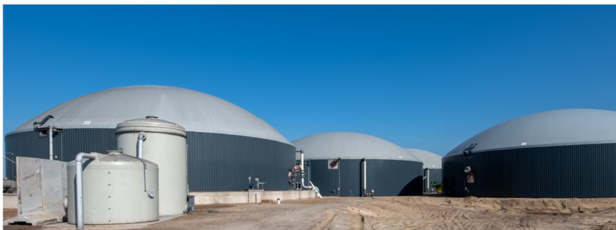
Figuur 8 vergistinginstallatie Harderberg, voorbeeld van een vergister
