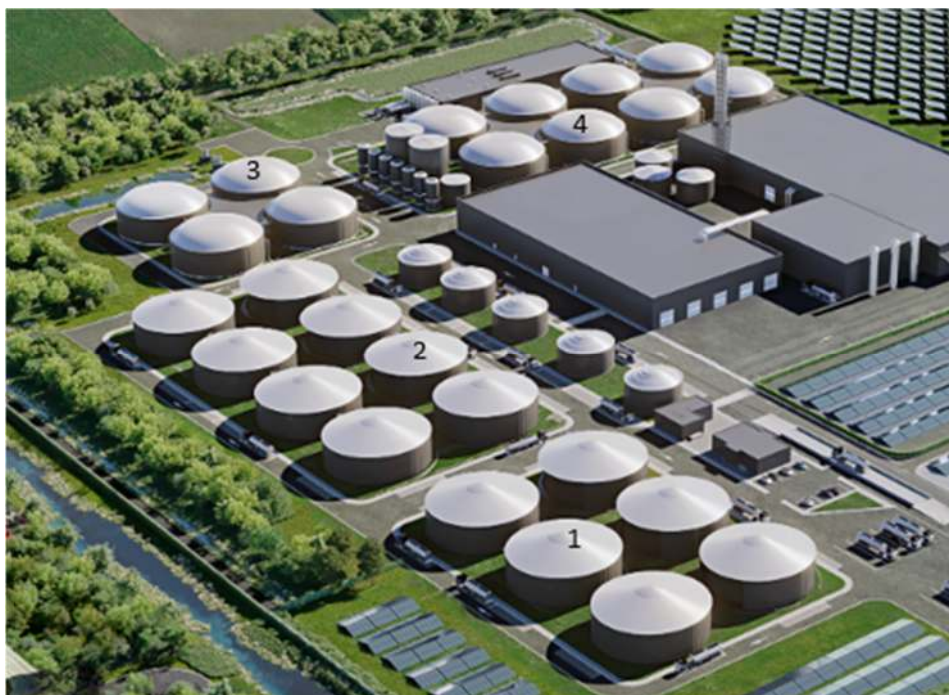
Figuur 25 overzicht installatie met 4 siloparken
