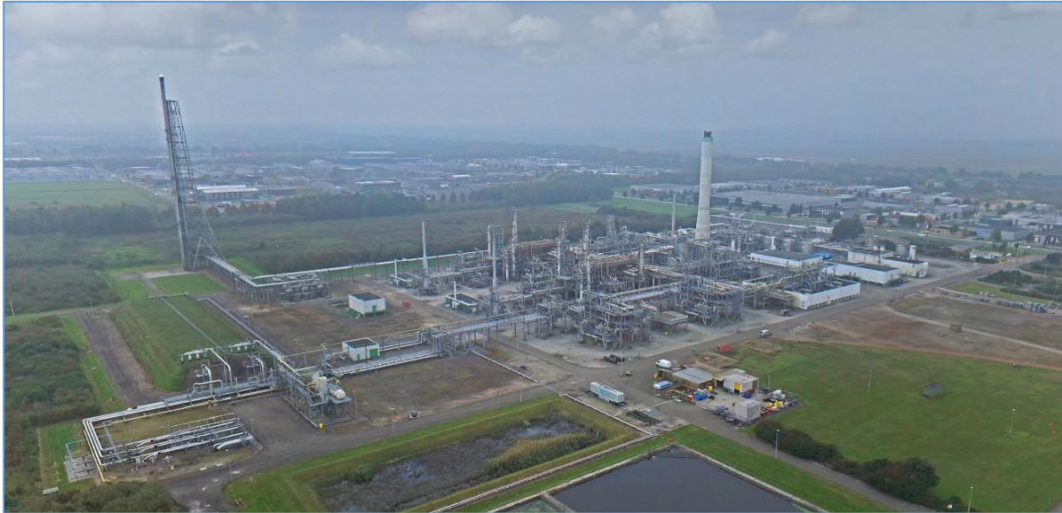
Afbeelding 2: Overzicht GZI-terrein (bron luchtfoto: NAM)
