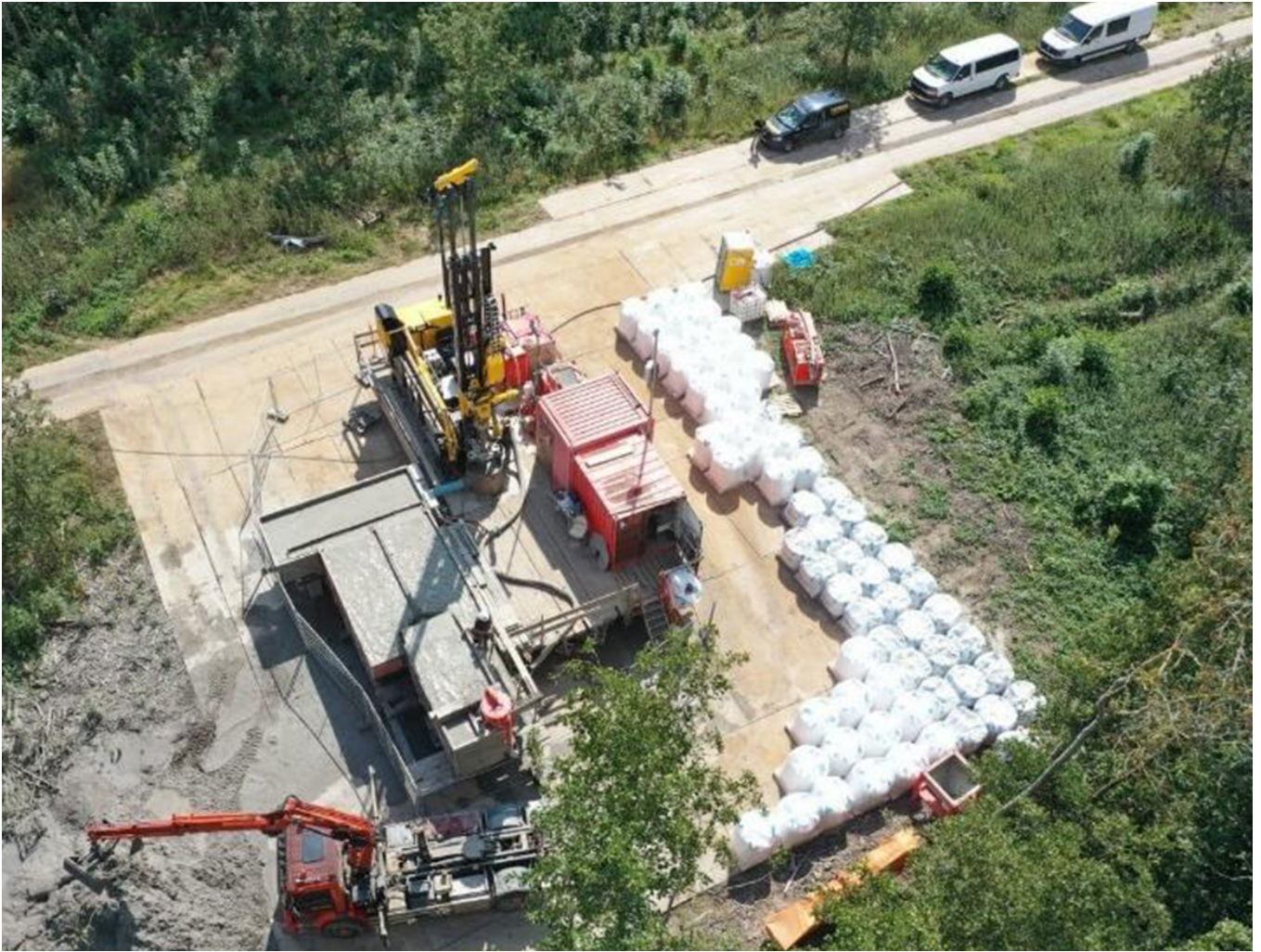
Figuur 11. Voorbeeld opstelling voor het boren van een winput (Zie ook deze blog over de pompproef)
