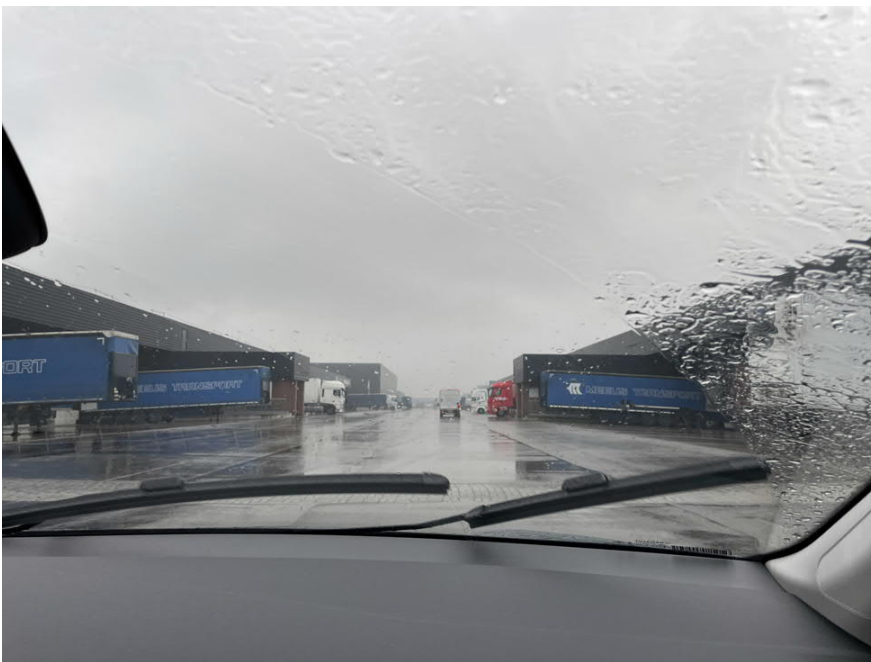
Afbeelding 4. Bestaande loodsen Noordland 12 t/m 16
