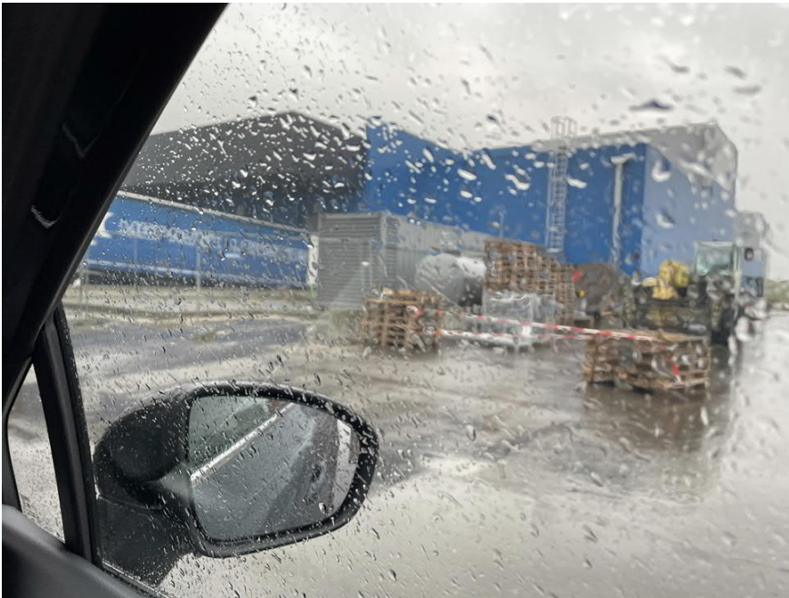
Afbeelding 3. Bestaande loodsen Noordland 12 t/m 16
