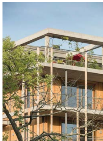
2.9 Gelaagdheid van de gevel draagt bij aan aangename beleving
