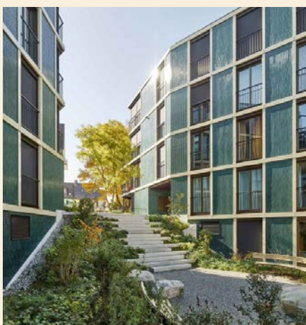
3.51 Open structuur met afwisselend ramen, dichte geveldelen, terugliggende entrees en balkons
