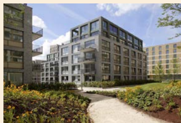
3.15 Optoppingen wijken af in materiaal of gevelindeling
