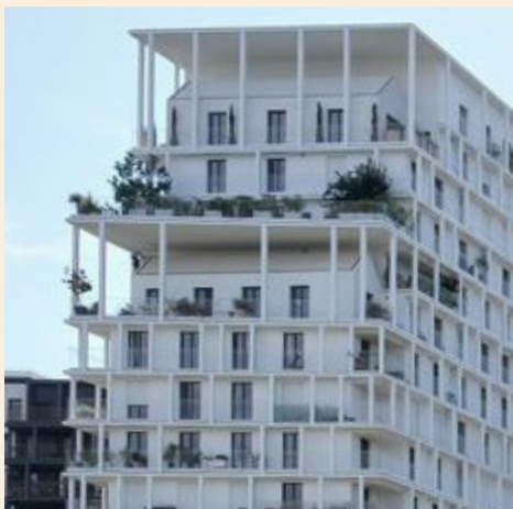
3.47 Geraamte van balkons; installatie dak uit het zicht en integraal mee-ontworpen
