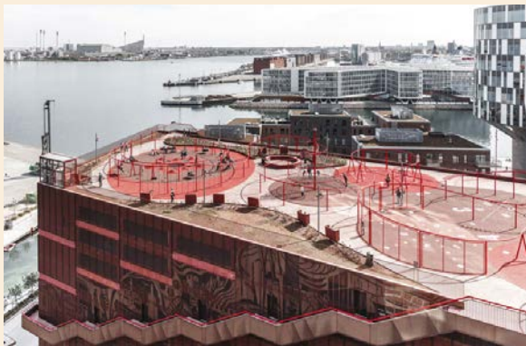
5.5 Parkeergebouw met sportfunctie op het dak
