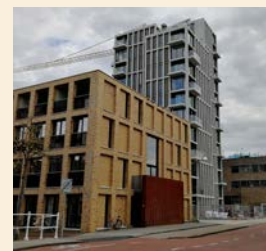
3.16 Blok samengesteld uit breed en laag volume naast een smal en hoog volume met afwijkende materialen
