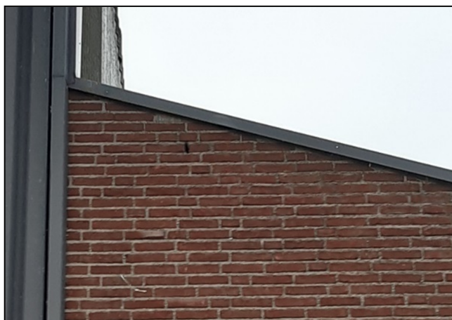
Figuur 4.2: Spouwgaten in de muren van het logistieke centrum.
