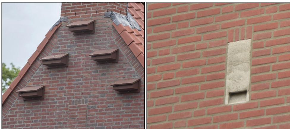
Figuur 3.3: Nestkasten voor gierzwaluwen (links) en inbouwkasten voor vleermuizen (rechts). (bron: Vivara)
