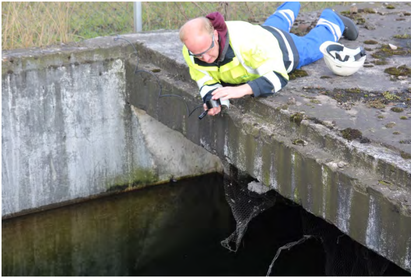
Figuur 2. Plaatsing van de microfoon in kelder 3.
