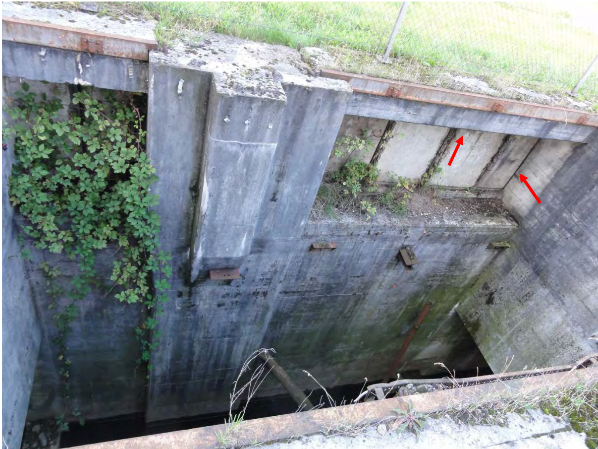
Figuur 4.2. Eén van de openingen in kelder 2. In de gehele noordwand van deze kelder zijn spleten tussen plafond en achterwand en zijwanden aanwezig waar vleermuizen kunnen verblijven.
