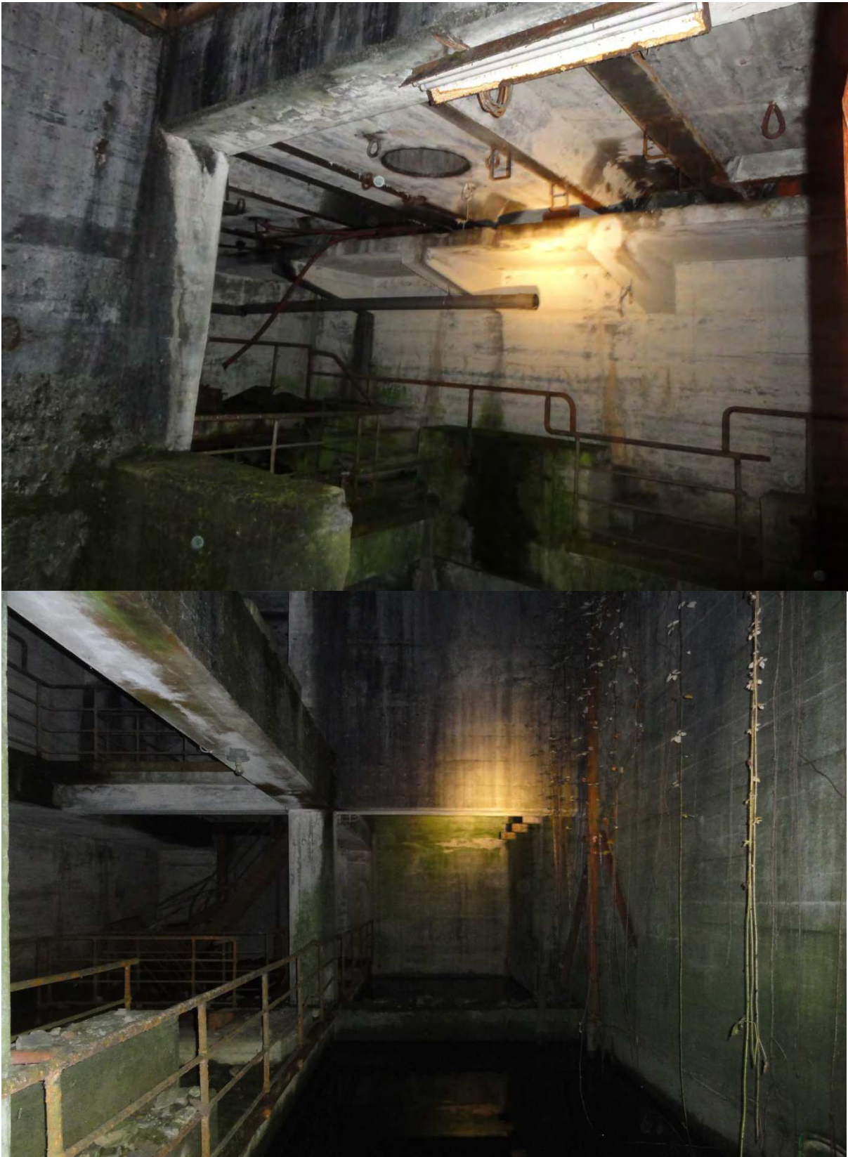
Figuur 4.3. Binnenzijde van kelder 2.
