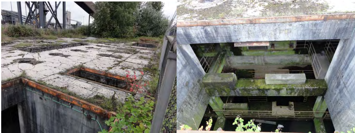
Figuur 3.3. Kelder 2 heeft aan het oppervlak meerdere openingen en heeft alleen op de bodem water staan.
