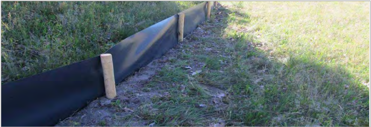
Afbeelding 3: Voorbeeld van een amfibiewerend scherm (binnenzijde). Door het gladde oppervlak zijn reptielen, amfibieën en kleine zoogdieren niet in staat om tegen het scherm op te kruipen. Foto: I. van Woersem.
