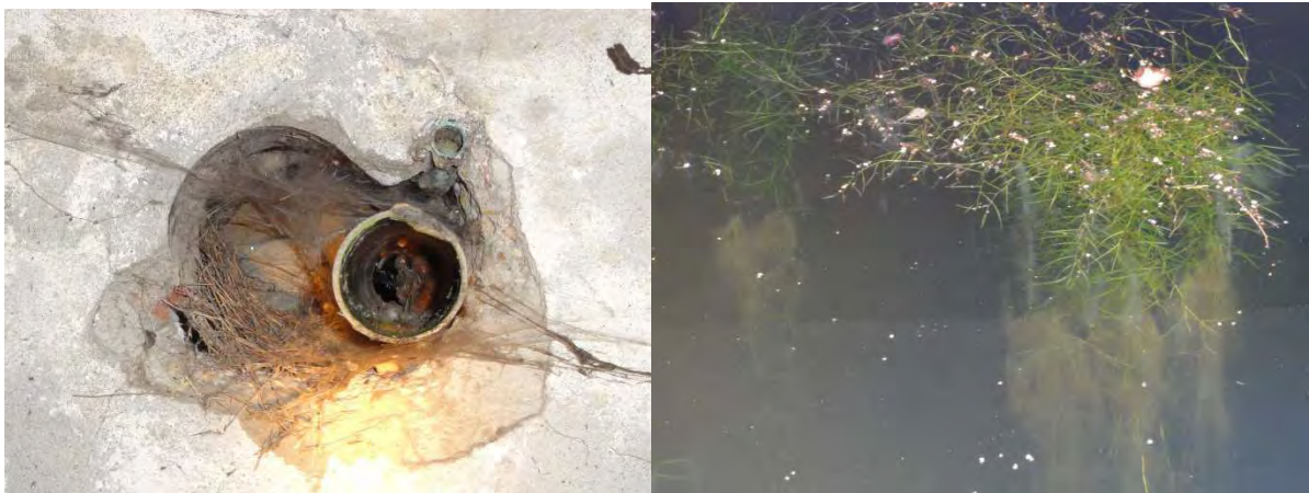
Figuur 4.4. Kelder 3 bevat nestmateriaal in een holte en waterplanten.
