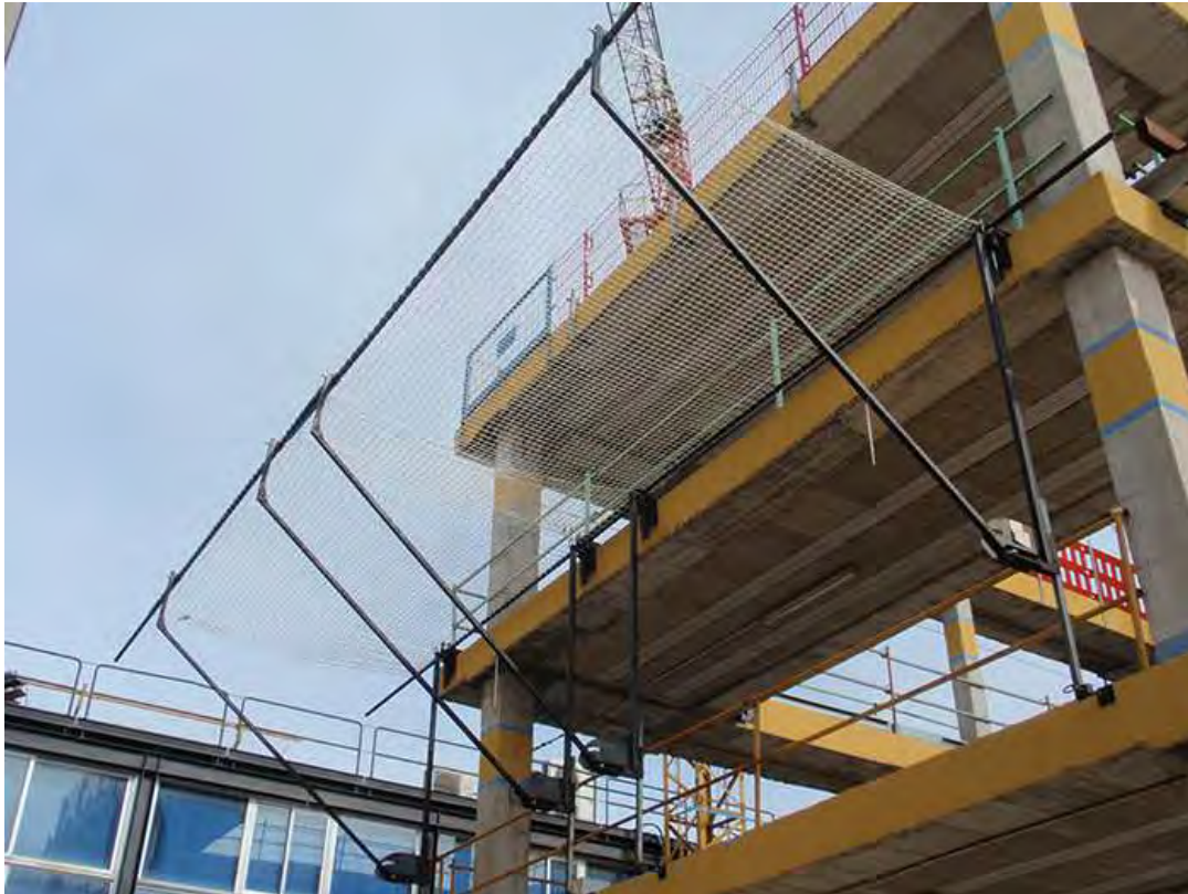
Afbeelding 6: Voorbeeld van een mogelijke vangnetconstructie.
