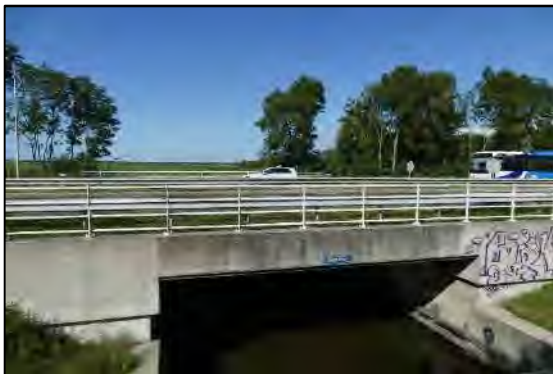
afbeelding 1.5. Locatie A, zuidzijde viaduct over Alddeel
