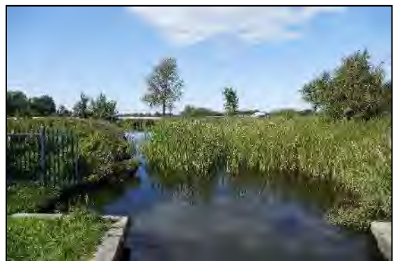
afbeelding 1.10. Locatie B, zuidzijde gemaal
