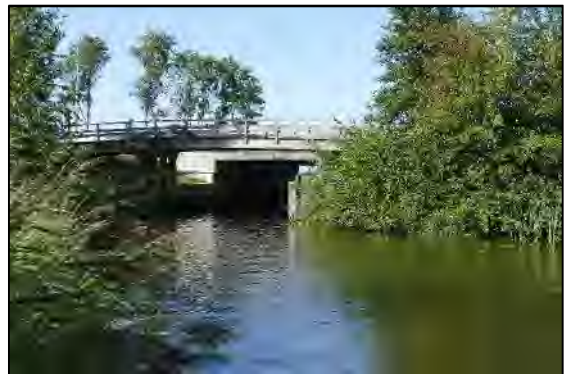
afbeelding 1.6. Locatie A, zuidzijde viaduct over Alddeel
