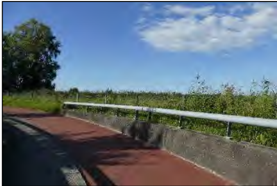
afbeelding 1.11. Locatie C, noordzijde fietstunnel.
