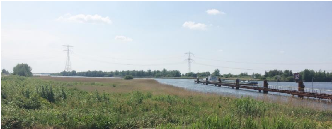
Figuur 1.1 Plangebied vanuit het oosten gezien
