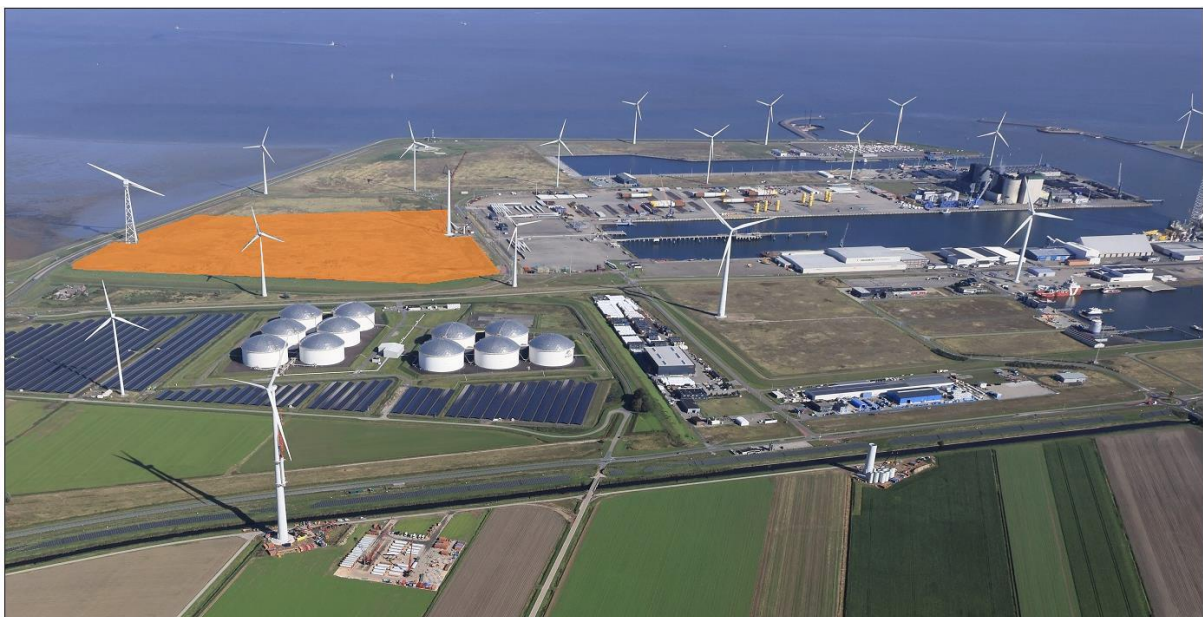
Afbeelding 11: de locatie Westlob gezien vanuit het zuiden, met de Julianahaven voor CO 2 -transport
