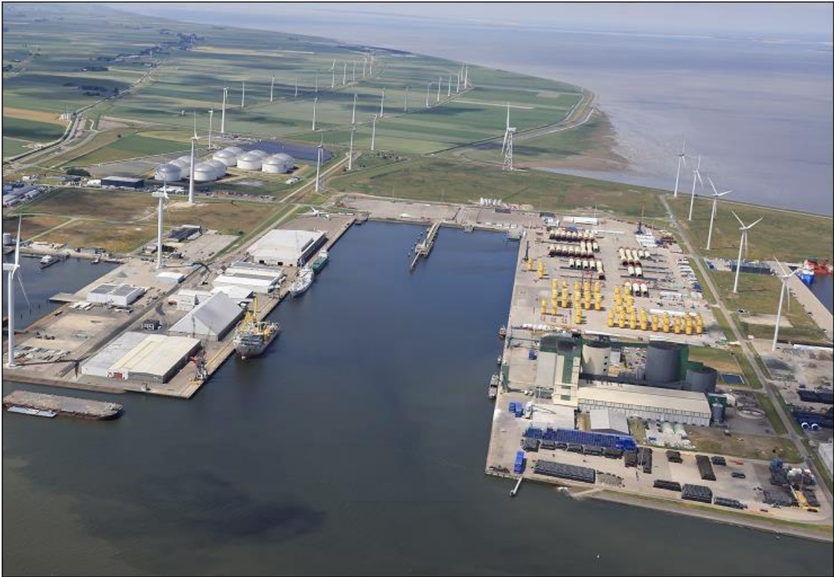
Afbeelding 12: de locatie Westlob gezien vanuit het oosten
