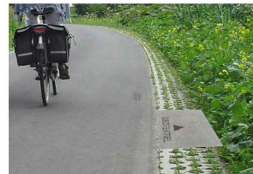
Referentie begin geotextiel
