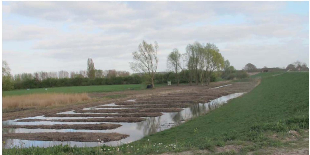
Hersteld rabbattenstructuur Beusinchemsewaard, als onderdeel van de dijkversterking Hagestein-Opheusden
