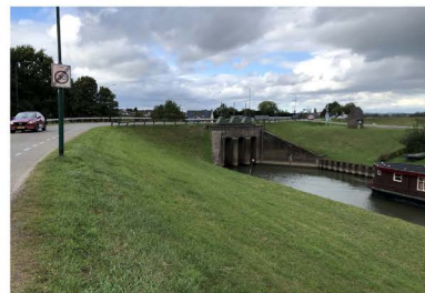
Aanzicht op de inundatiesluis vanuit het zuiden
