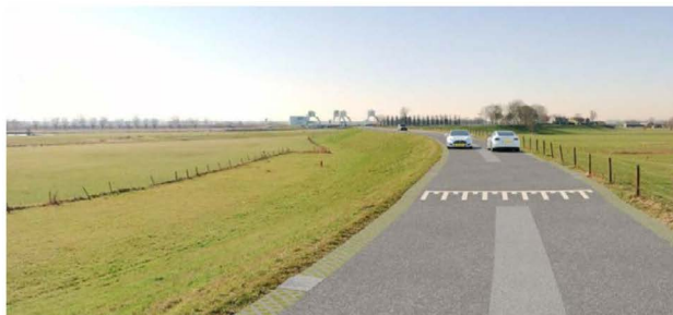
Standaard-plateau met onderbreking van de loper (coating)
