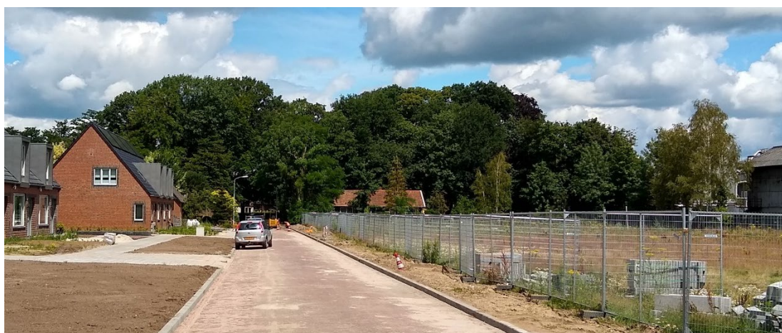
Figuur 3.8 braakliggend terrein ter hoogte van gesloopte woningen
