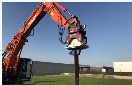
Hydraulische kraan met trilblok voor inbrengen korte damwandplanken
