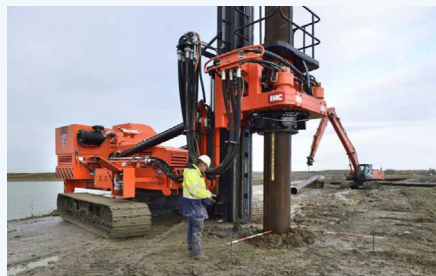
Tubex stelling voor boren buispalen
