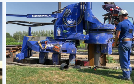
Compacte drukmachine voor het drukken van damwanden
