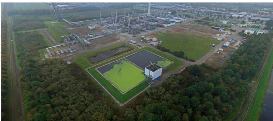
Luchtfoto GZI-locatie bestaande situatie
