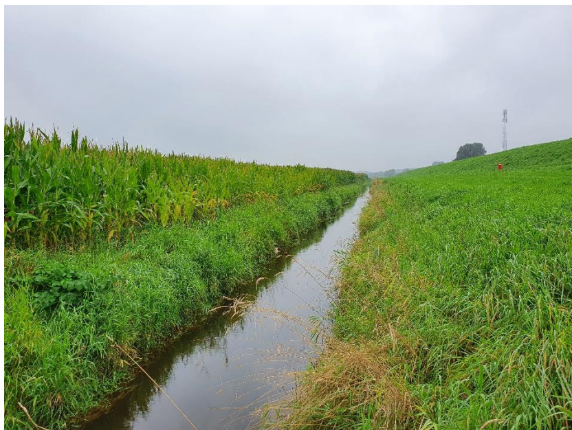
Figuur 2.5 Sloot en akker ten zuiden van de dijk
