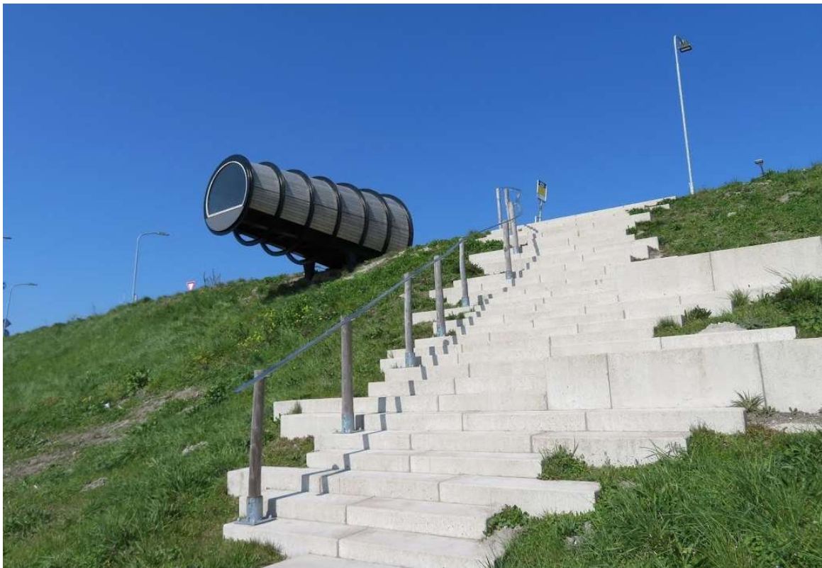
Figuur 23: Dijkmeubilair in de haven van Lauwersoog – foto binnentalud bij dijkspaal 90.0.
