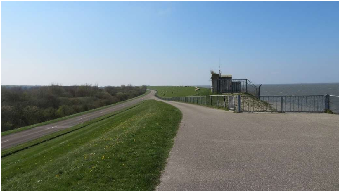
Figuur 21: Foto dijkovergang op het landelijke deel van de Lauwersmeerdijk – foto bij dijkspaal 86.5.
