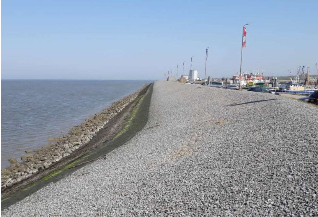
Figuur 8: Foto van de dijkbekleding op de oostelijke havendam (van beneden naar boven; stortsteen, koperslabblokken, asfalt)
