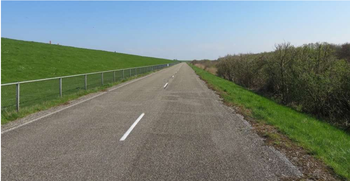
Figuur 20: Foto landelijke deel van de Lauwersmeerdijk – foto bij dijkspaal 84.0.
