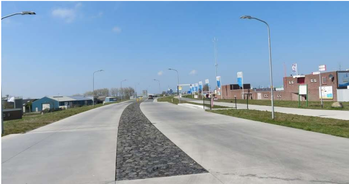
Figuur 22: Kruihaven Lauwersoog – foto binnentalud bij dijkspaal 90.2.
