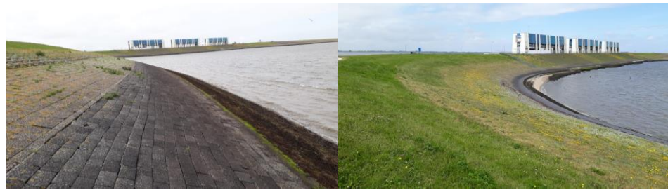
Figuur 115 Impressie van de zetsteen op de havendam
