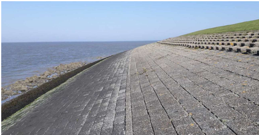
Figuur 6: Foto van de dijkbekleding op de westelijke havendam (van beneden naar boven; stortsteen, koperslabblokken, betonblokken, diaboolglooing en gras)
