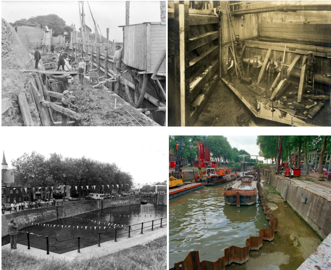
Figuur 2.3a-d. Afbeeldingen van de bouw en latere onderhoudswerkzaamheden aan de Oude Sluis in Vreeswijk.
