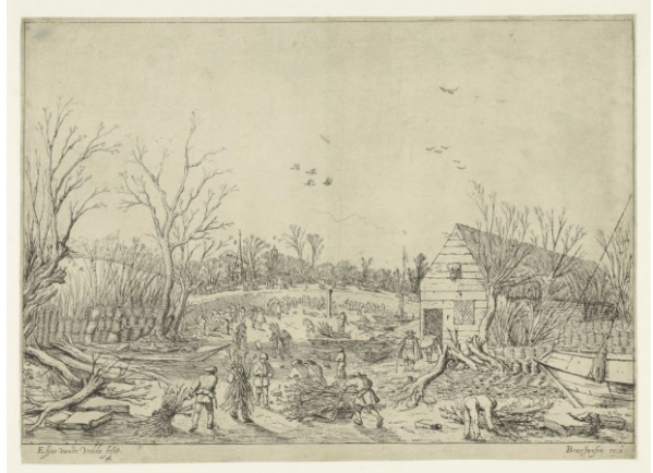
Figuur 2.10. Tekening uit de 17 e eeuw van herstelwerkzaamheden van de doorgebroken Lekdijk
