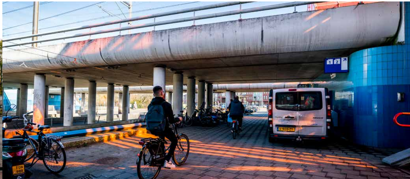
Bepaalde voorzieningen rondom station Moerwijk // Bron: Valerie Kuypers
