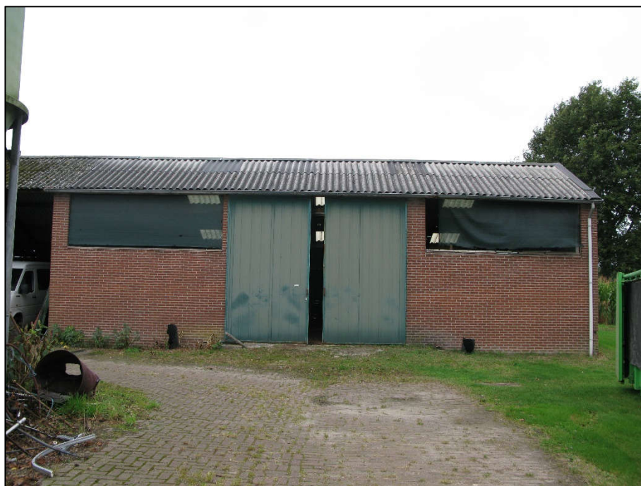
Figuur 8: Bijgebouw C1 (wordt gesloopt)
