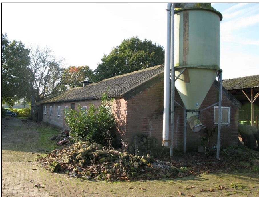
Figuur 7: Bijgebouw B2-B3 (wordt gesloopt)
