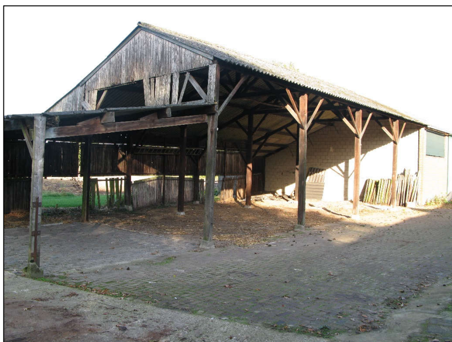
Figuur 9: Bijgebouw C2 (wordt gesloopt)
