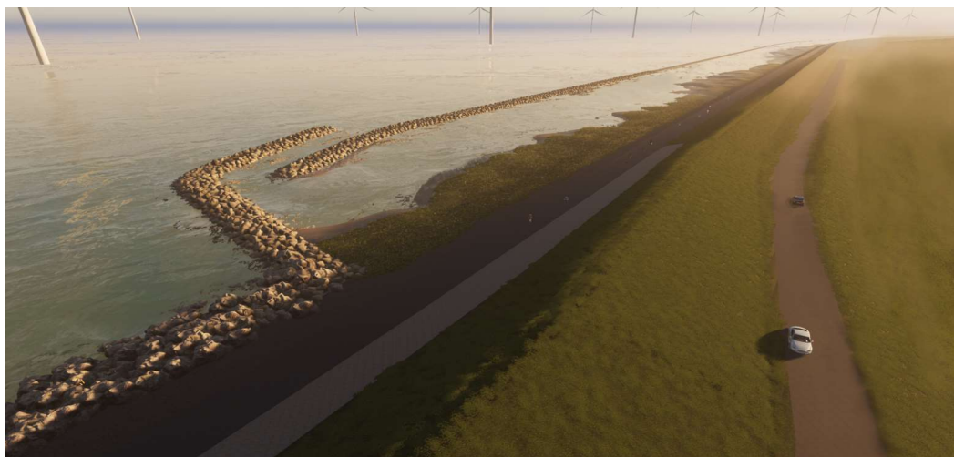
Figuur 5-1: Visualisatie van de overgang tussen de Vooroever naar een alternatief met een traditionele versterking
