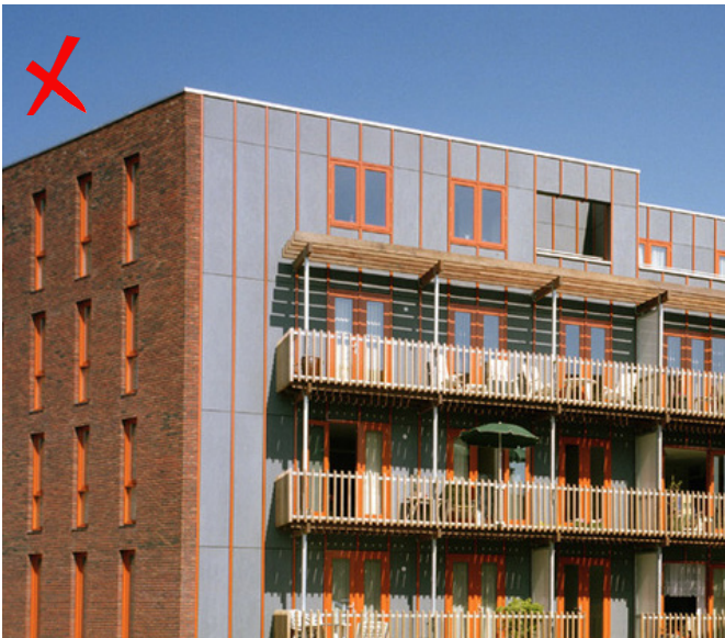
De galerij als toegevoegd losstaand element.
