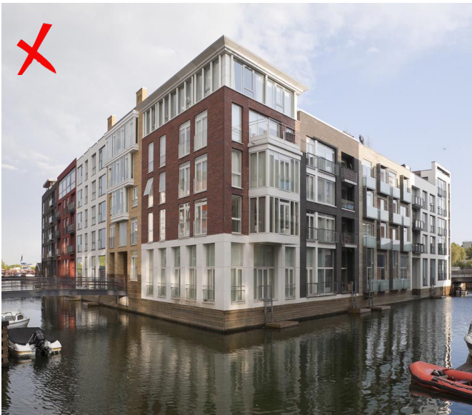
Bouwblok is opgesplitst in uiteenlopende architectonische eenheden.
