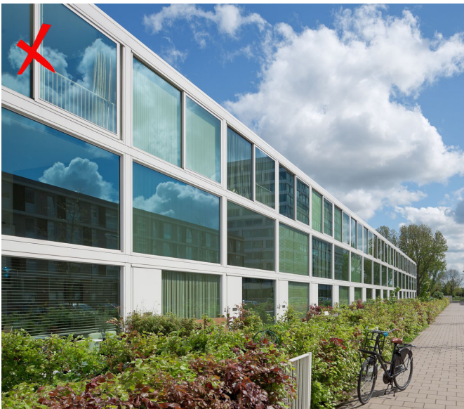
Te weinig articulatie van de woningen onderling.
