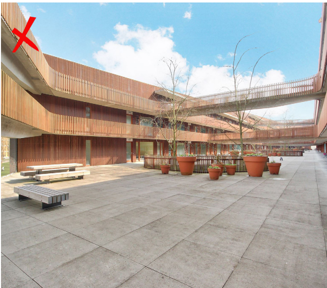
Deck van parkeergarage volledig verhard.
