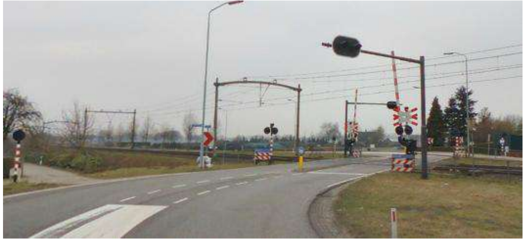
Figuur 3: Huidige overweg Kapelweg
