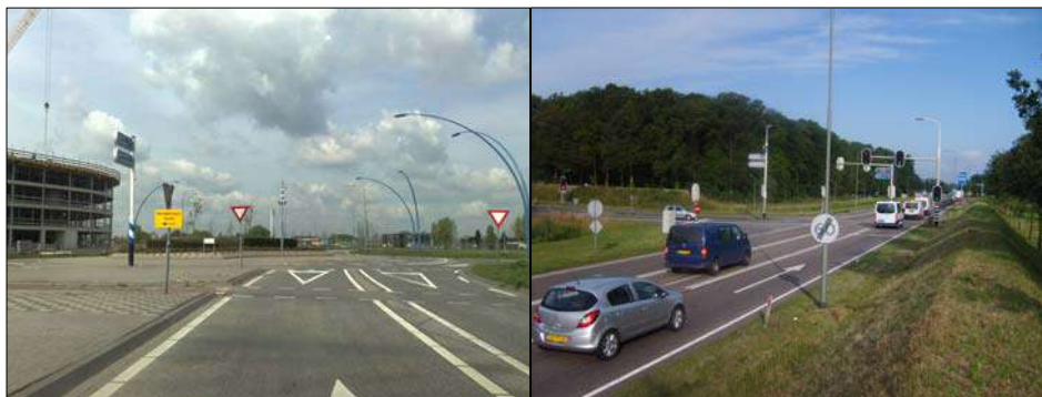
Foto 3.1 en 3.2: Op de turborotonde Keulsebaan – Bloemmolen (links) en de westelijke aansluiting van de A2 op de Keulsebaan (rechts) ontstaan in de huidige situatie geen afwikkelingsknelpunten
