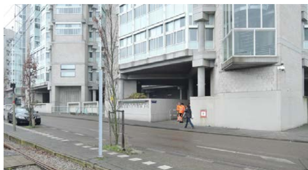
Onaantrekkelijke plinten, gesloten, dode hoeken (onoverzichtelijke nissen)
