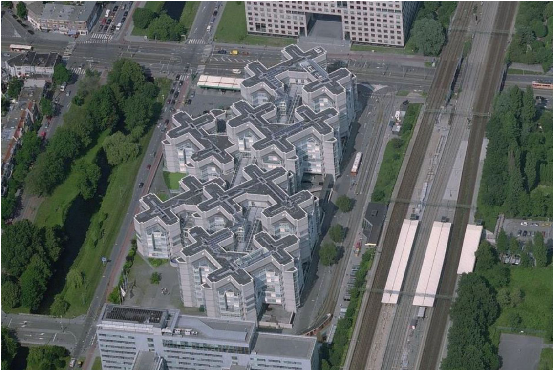
Figuur 2.2 Het bestaande gebouw op de locatie Anna van Hannoverstraat 4
