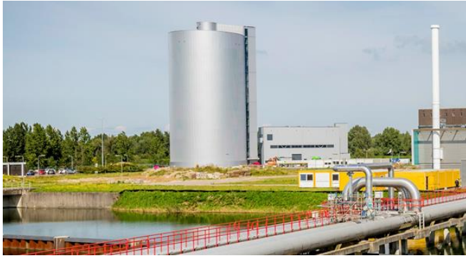
Afbeelding 1.12 Bovengrondse warmteopslagtank Diemen
