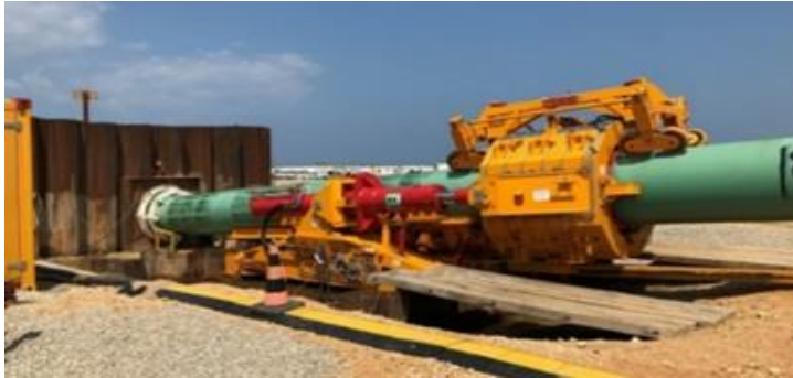
Figuur B20 - DGB-G techniek toegepast Hak project in Israël, de onshore locatie (A. Hak)
