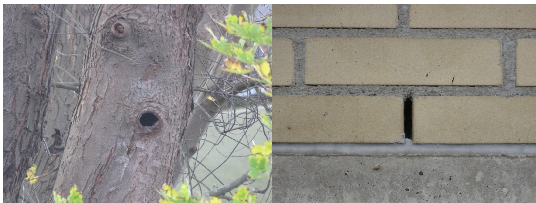
Figuur 3.3 Voorbeelden van geschikte verblijfplaatsen voor vleermuizen. Links een holteboom, rechts een open stootvoeg richting een spouwmuur
